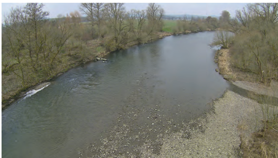
Abb. 8: In die Eder im Zuge der Renaturierungsmaßnahmen eingebautes Kies- und Schottermaterial
